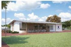
カフェ棟外観
